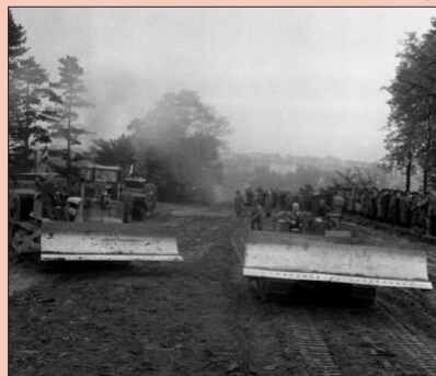
Le maire Louis Pradel se renseignait presque quotidiennement sur l'avancée du chantier. Quitte à piloter lui-même un bulldozer. Photo d'archives Le Progrès
